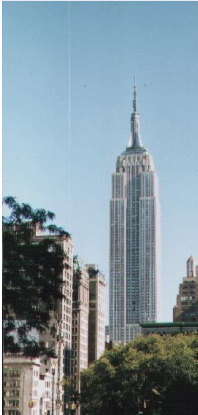
Figuur 1.3: De bekende hoge gebouwen waren voor het publiek gesloten.
